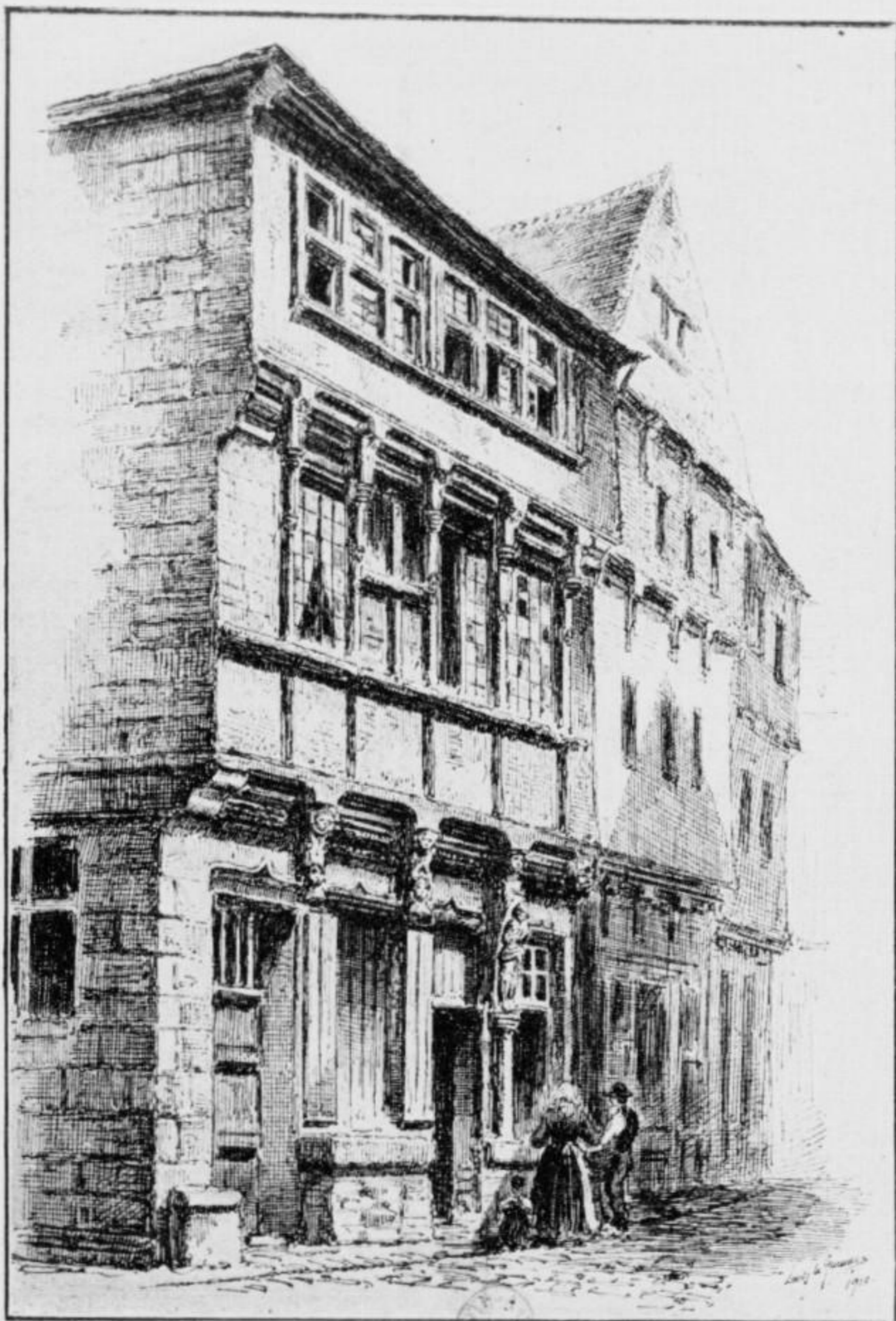
MAISON DES EDER, rue Saint-Jacques, à Saint-Brieuc.
